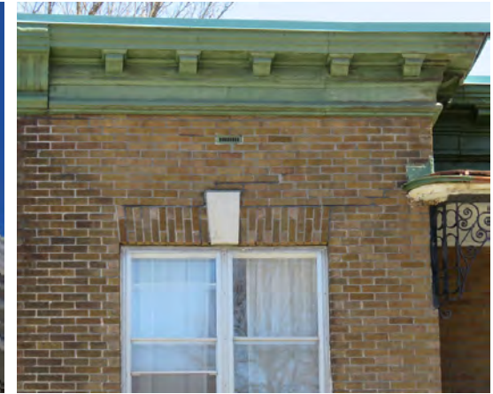
Corniche à modillons et à console d'arrêt (extrémité gauche). 365-381, boulevard René-Lévesque Ouest.
