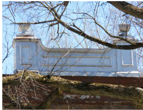
Balustrade de couronnement sur le sommet du toit du 387-391, boulevard René-Lévesque Ouest.
