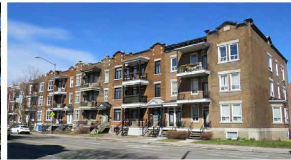
Triplex érigés par Wilfrid Légaré en 1926-1927. 504 à 506, boulevard René-Lévesque Ouest.
