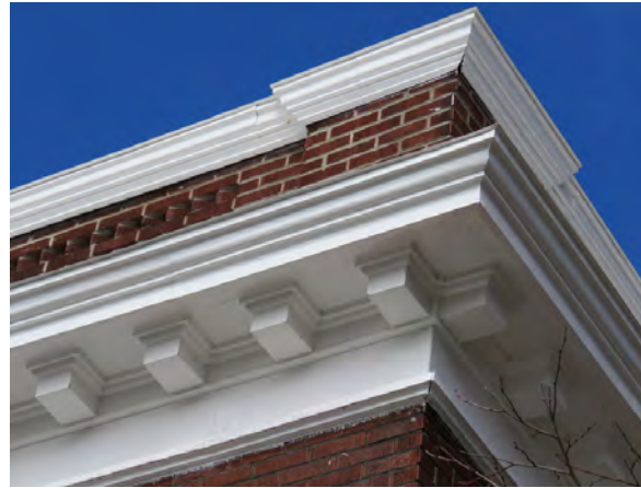
Corniche à modillons et en haut, corniche à ressauts. 652, boulevard René-Lévesque Ouest.
