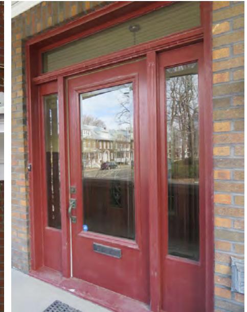
Porte à baies latérales et à imposte. 1015, avenue Brown.
