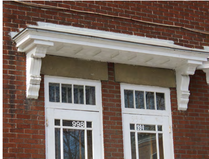
Toit supporté par des consoles surmontant des portes jumelées. 652, boulevard René-Lévesque Ouest/ 994-998, avenue de Bougainville.
