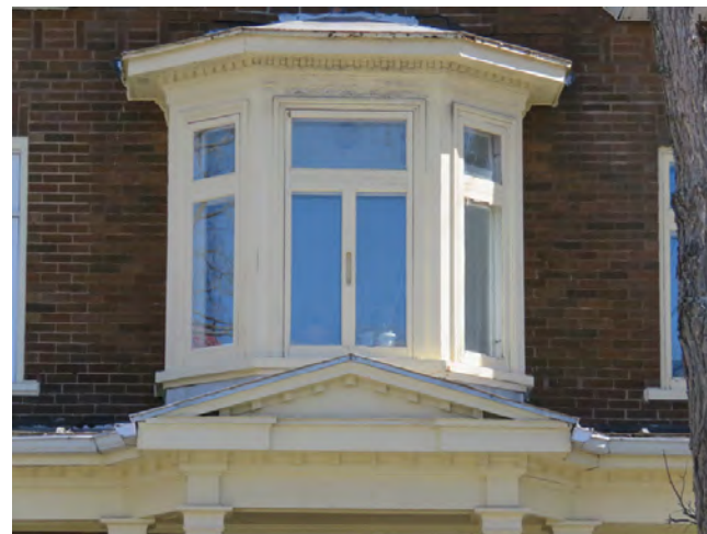
Logette à trois pans surmontant un fronton. 605, boulevard René-Lévesque Ouest.
