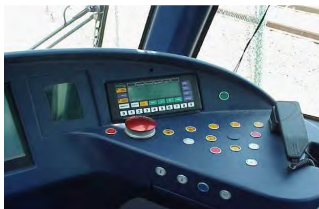
Figure 20 : Photo des boutons de commande d'une cabine de conduite
