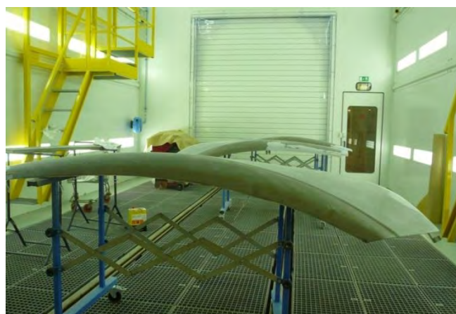
Figure 41 : Exemple cabine de peinture - Rouret-France
