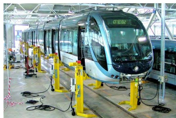
Figure 39 : Exemple du système de levage Bordeaux - France
